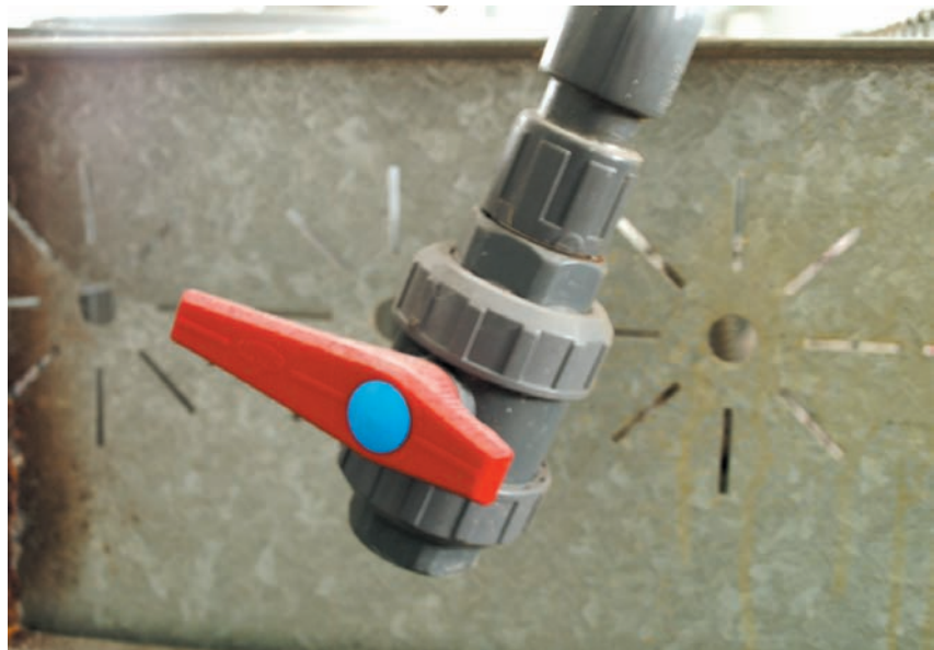
Las tuberías tienen un grifo al final del recorrido que permiten realizar una buena limpieza de ellas en cada ciclo
