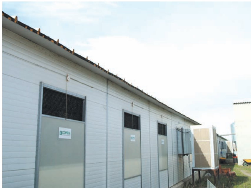
Las ventanas están conectadas a una sonda que las abre y cierra automáticamente según las necesidades ambientales
