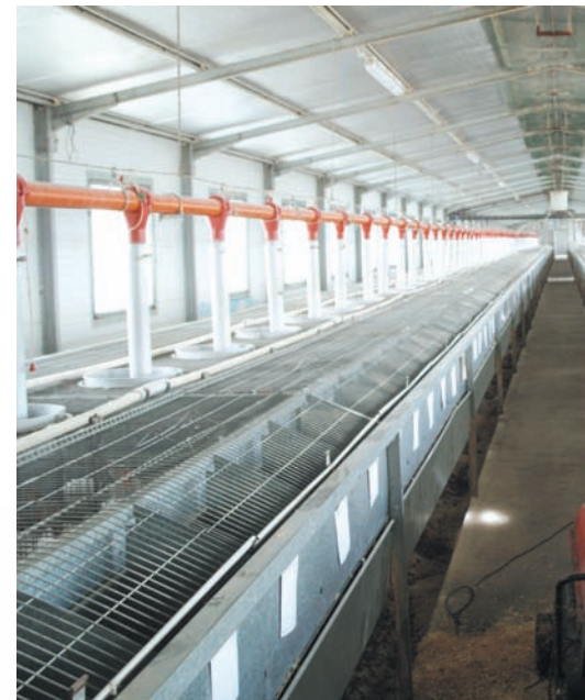
Vista general de la nave con el calefactor de gasóleo
