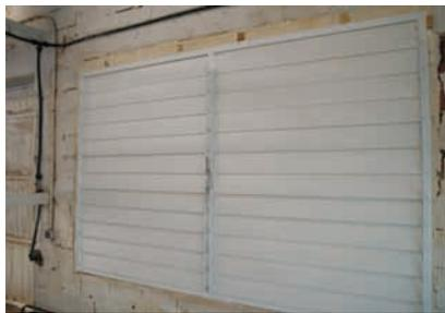
La entrada de aire del exterior esta regulado mediante lamas que evitan que el aire contacte directamente con los animales
