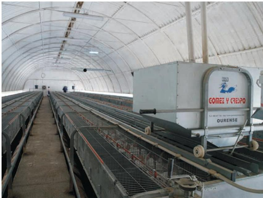
Vista general de la nave. A media nave se observa el tubo de entrada del aire caliente mediante el sistema de biomasa.
