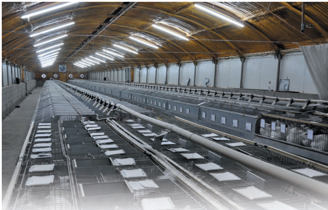
Granja Rofadouro. Vista de la nave donde se pueden apreciar los extractores en el fondo, así como el extractor de soporte por encima de ellos.
