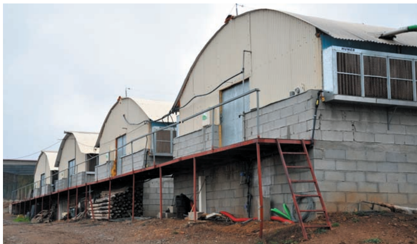
Vista exterior de los túneles de la explotación Rufadouro.
