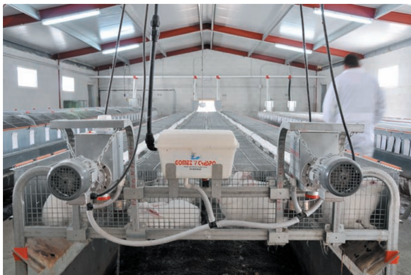
La alimentación es mediante bisenfin y al inicio de cada línea hay un depósito regulador de presión del agua
