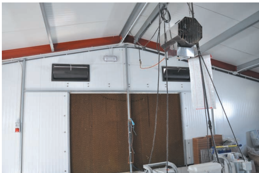
Sistema al completo de control de temperatura. Paneles, aberturas superiores y calefacción a gas
