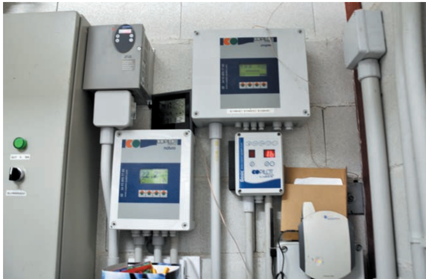
Vista del cuadro eléctrico que controla la temperatura de las naves
