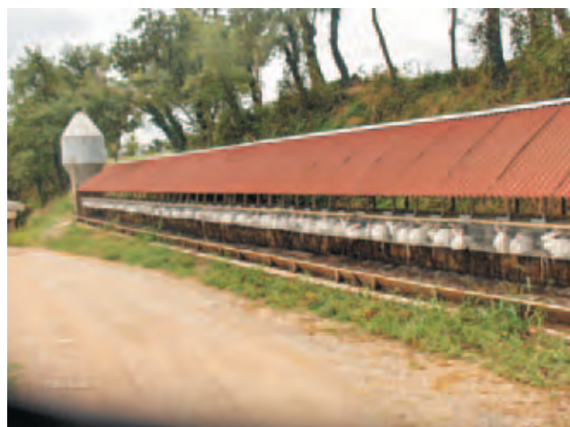
Vista de la nave destinada exclusivamente para la reposición
