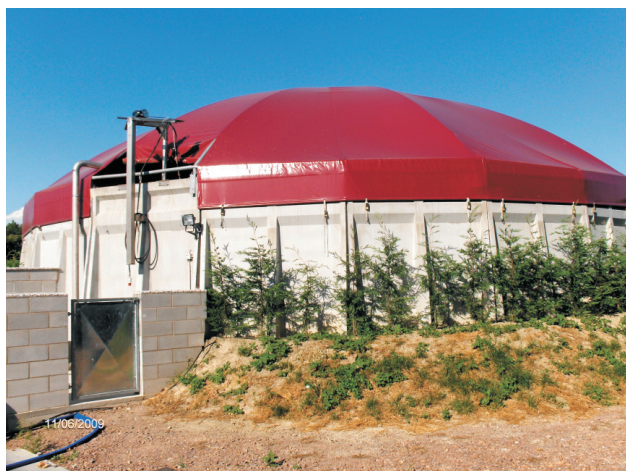
Depósito de almacenamiento del estiércol.
