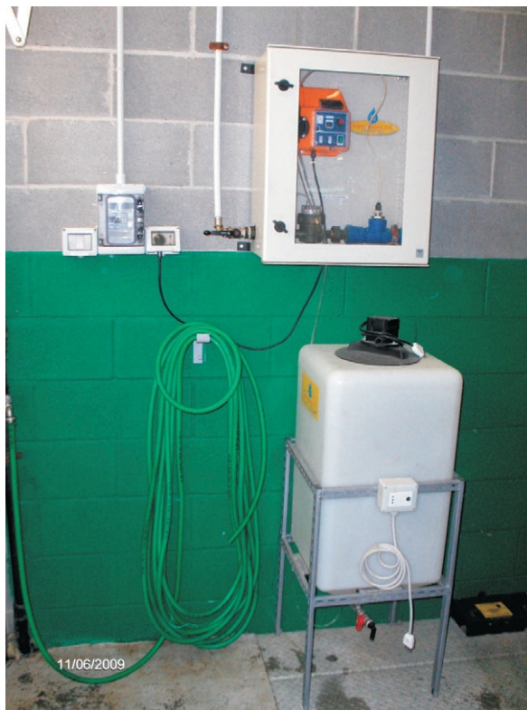
Dosificador automático y mezclador para medicaciones en agua. Nótese la protección del sistema contra el polvo y pelo.
